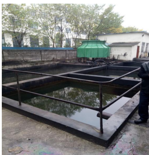
循环冷却水池
